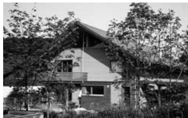
Ostfassade des in Holzsystembauweise errichteten Doppel-einfamilienhauses. (Fotos: VHe/Infoenergie)
