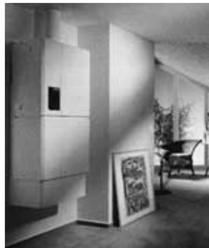
Kondensierende Gasthermen wie diese können sehr hohe Wirkungsgrade erreichen. Der Mehrpreis bei der Beschaffung ist gering, der Gewinn jedoch beachtlich.
