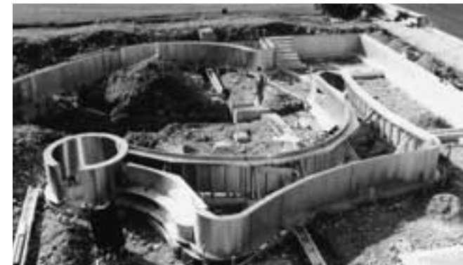
An diesem Bild aus der Montagephase eines Edelstahlbeckens lässt sich ohne viele Worte gut die Möglichkeit der freien Beckengestaltung erkennen.
