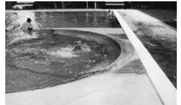
Gut erkennbar ist die Gestaltungsmöglichkeit mit überfluteten Flächen und deren Vorteil: gerader rechteckiger Grundriss mit einfacher Überlaufrinne und trotzdem die Möglichkeit, Buchten oder Nischen im Becken vorzusehen
