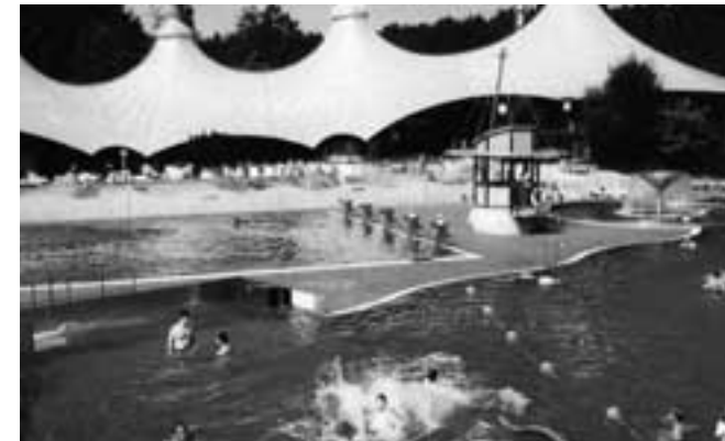
Die Anordnung der Schwimmmeisterkabine auf einer Halbinsel und die darum angeordneten Wasserflächen mit der geschwungenen Beckenform prägen diese Wasserflächen. Noch mehr ist diese Anlage aber durch die zeltartige Bedachung der Hochbauten im Hintergrund geprägt.
