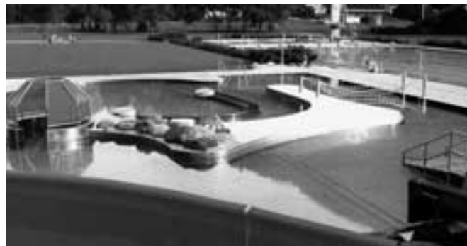
Auch mit Edelstahl können freie Formen, wie hier die Insel mit angrenzendem Strömungskanal und der Schaukelbucht gebaut werden – und es entstehen keine Probleme mit der Dichtheit der umgebauten Becken.
