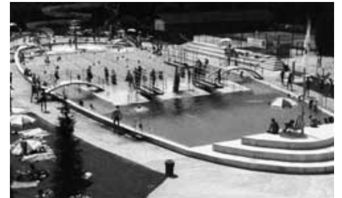
Hier wird ebenfalls ein Schiff als Motiv verwendet, aber als Grundform der gesamten Beckenanlage. Im Vorderteil befindet sich der Nichtschwimmerbereich, dazwischen der 25-m-Sportteil und im Heck das Sprungbecken. Zur Betonung der Schiffform wurde das Becken herausgehoben.
