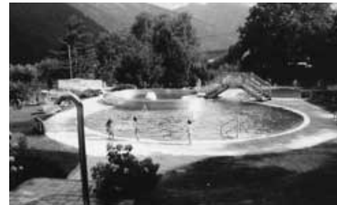
Eine Lösungsmöglichkeit für den Einbau einer Wellenanlage (schwingende Kugel) mit einfachen Mitteln in der Beckenanlage zeigt dieses Bild.
