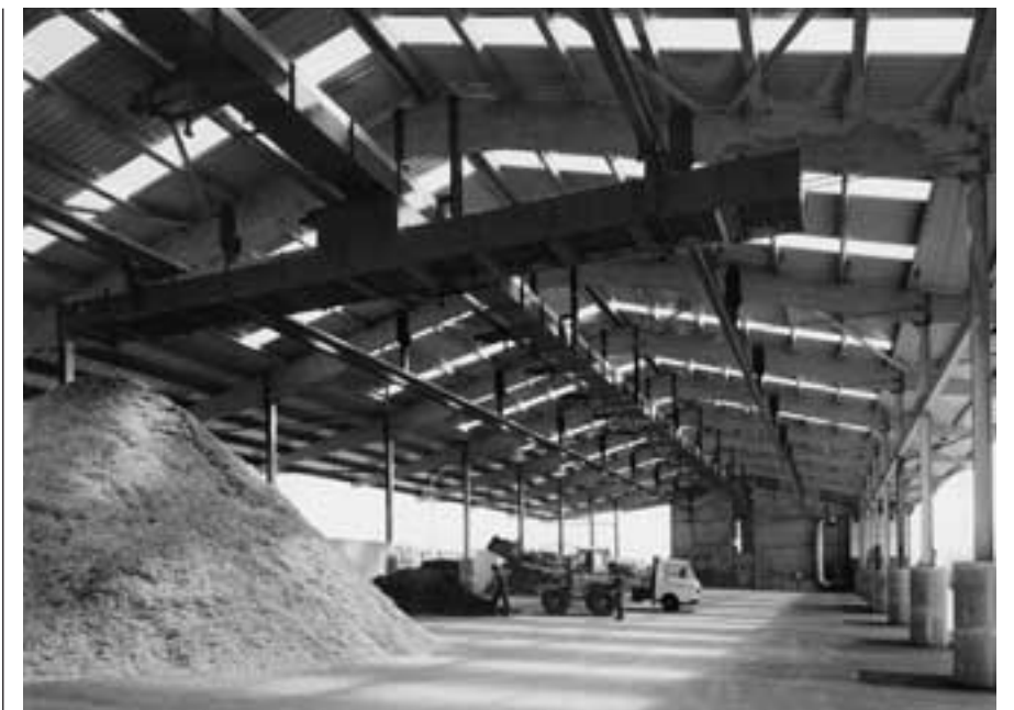
Altholzaufbereitung und Lagerung bei der Alfred Müller AG in Baar ZG. (Foto: Alois Ottiger, Zug/zvg)
