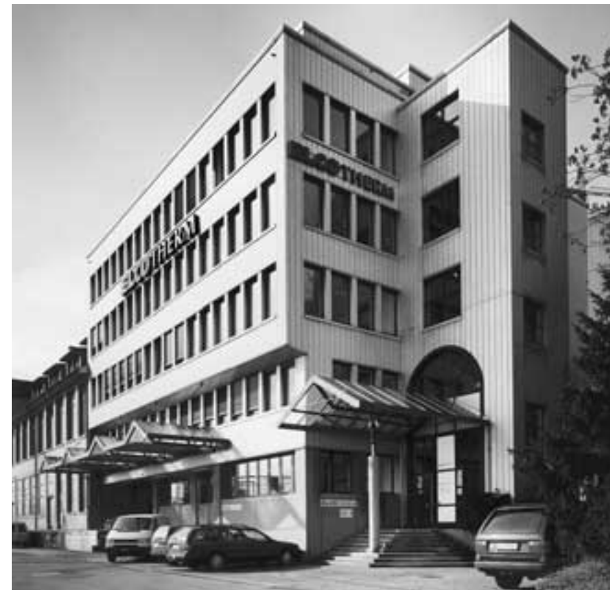
Verwaltungsgebäude der Elcotherm AG in Horgen ZH.
