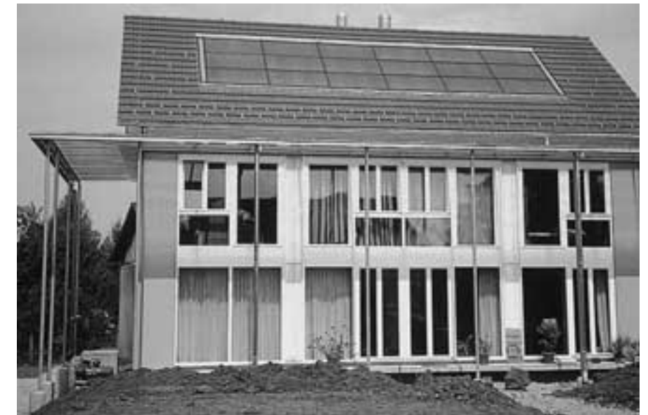
...und eine Solaranlage liefert erneuerbare Energie für die Wärmeherstellung. (Fotos: Flumroc AG)
