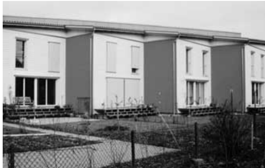
Passivhausssiedlung Wegere in Nebikon LU.
