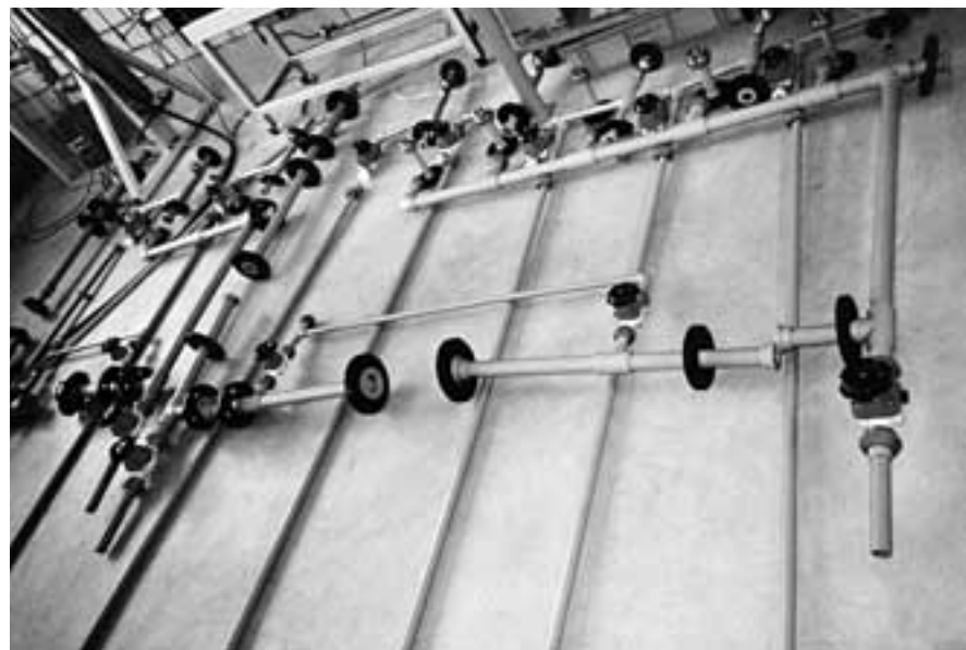
Baugruppen für die Verteilzentrale der Kinderklinik des Inseleospitals in Bern wurden bei «Georg Fischer» in Schaffhausen vorgefertigt. (Fotos: Georg Fischer)
