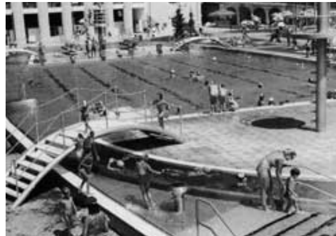
Die Planung dieses Projektes konnte sehr grosszügig erfolgen. Der Gedanke eines Schiffs als Form der Anlage wurde auch in den Details konsequent verfolgt. Brücken wie im Hafen, Poller, Mastkorb sowie die Strömungskanalführung sind zu sehen.
