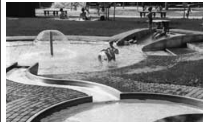
Kinderbecken mit verschiedenen hohen Wasserspiegeln erlauben den Einbau von Verbindungskanälen zum Schwimmenlassen von verschiedenen Gegenständen, was aber noch viel wichtiger ist, den Bau von «Wasserrutschen» für die Kleinen (Hintergrund).
