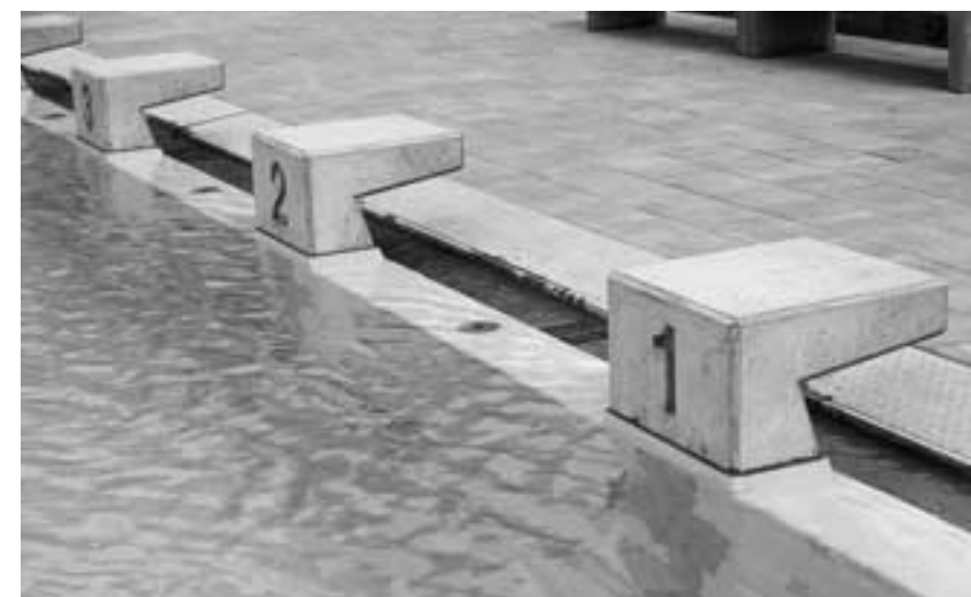
Beckenkopf in Elementbauweise mit Folienauskleidung.
