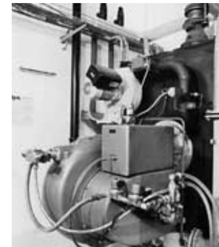
Brenner mit Rauchgasrückführung.
