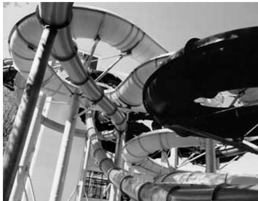
Warmwasserzuführung für sechs gigantische Rutschbahnen im Aquaparc in Bouveret VS.
