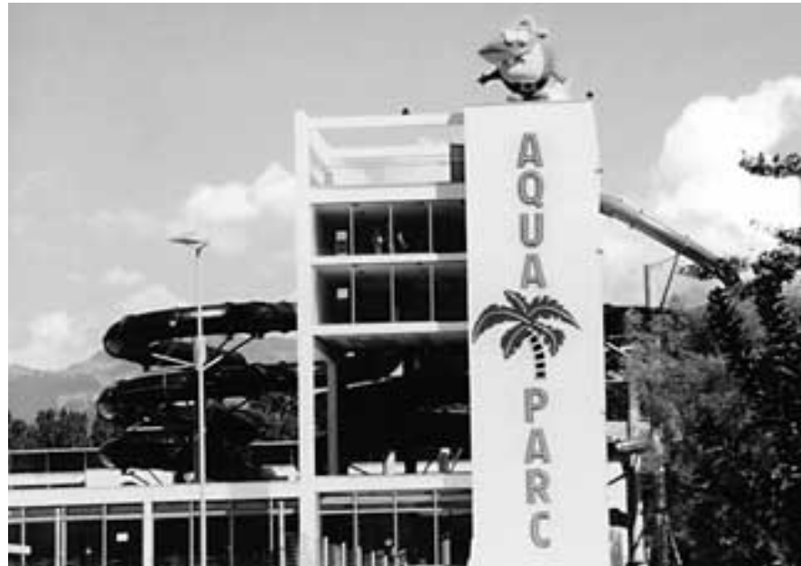
Rund 60 000 m 3 Bauvolumen: Aquaparc Bouveret VS.
