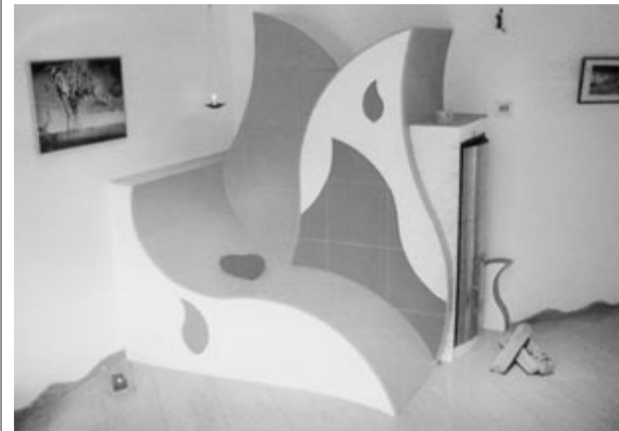
Ein Meisterstück in Sachen Ofenbau – der Kachelofen von Roger Pernet, Steckborn: ein Pufferspeicher, kombiniert mit Wandheizung, Bodentemperierung und Brauchwasseraufbereitung; geheizt wird mit Stückholz. (Foto: Roger Pernet)
