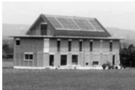
Blick auf das in Holzbauweise erstellte Passivhaus in Hünenberg ZG.
