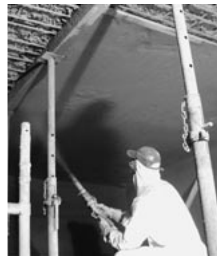
Applikation von Sika MonoTop-612 im Nassspritzverfahren. (Fotos: Matthias Dietrich/Sika AG)
