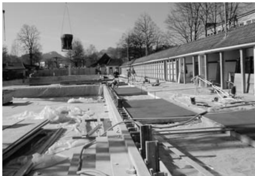
Betonieren der Beckenumgänge im März 2002.
