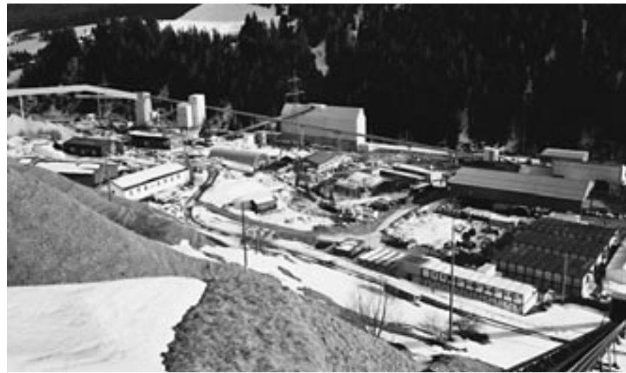
Aussenanlage Baustelle mit Förderband.
