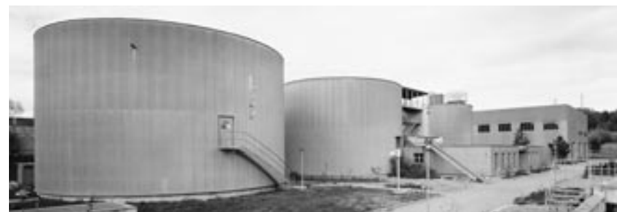
Teilsicht der Kläranlage Furt in Bülach; im hintersten Gebäude befindet sich die Klärschlamm-Trocknungsanlage. (Fotos: Peter Morf, Zürich/VSG)
