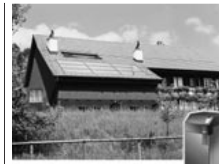
Die Solaranlage liefert Energie für die Warmwasseraufbereitung und der Heizkessel für die Wärme im Haus. (Fotos: Weishaupt AG)
