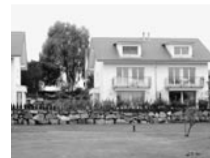
Für jedes dieser vier Häuser in Emmenbrücke muss eine Wärmeleistung von 6 kW bereitgestellt werden.
