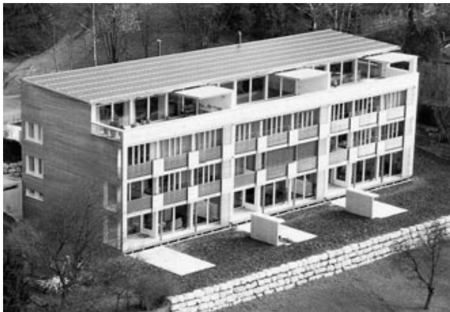
Das mit dem Solarpreis 2002 ausgezeichnete Gebäude «Sunny Woods» in Zürich stellt ein nachahmungswürdiges Beispiel der Integration verschiedener moderner Technologien dar, u.a. auch von Vakuum-Isolations-Platten (VIP).
