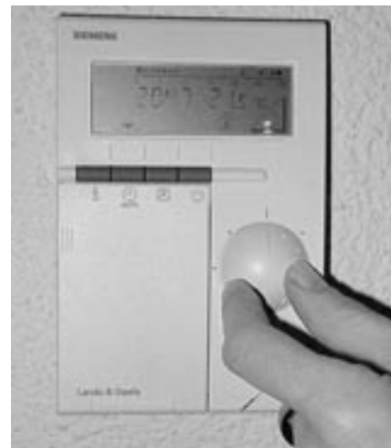
Raumbediengerät im Wohnzimmer. Ständig angezeigt werden Heizphasen, Aussen- und Raumtemperatur.
