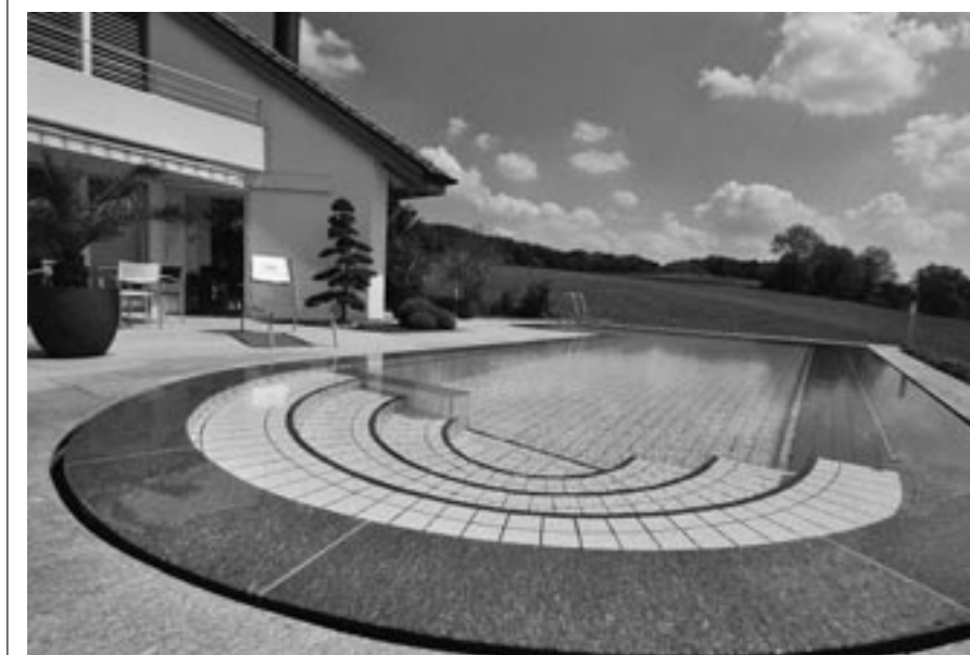
Betonbecken mit Keramik-Auskleidung, überflutend.
