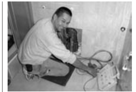
Jean-Michel Maury ist begeistert von der Heizwendelschweisstechnik, mit der auch in engsten Räumen Platzschweissungen vorgenommen werden können.
