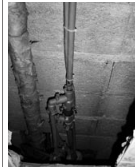
Die 11 m langen Steigleitungen für drei Stockwerke konnten einfach in der Werkstatt vorgefertigt werden.
