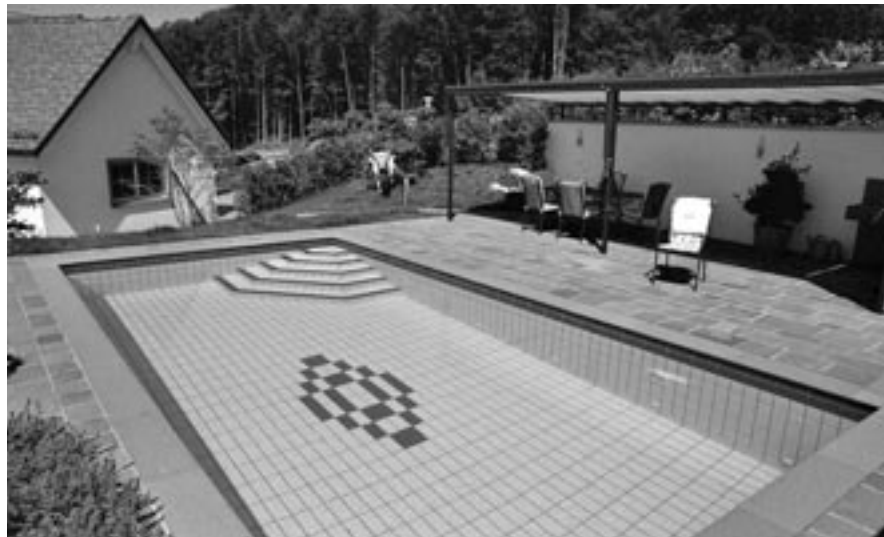
Betonbecken mit Keramikauskleidung, mit Gartenhalle.
