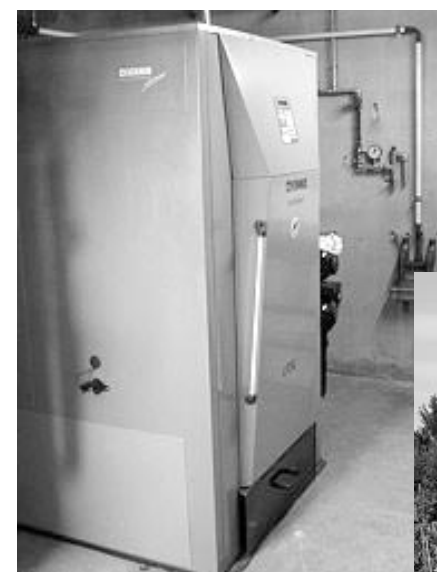
Im Kapuzinerkloster Schwyz (mittleres Bild) steht ein «Schmid UTSL»-Heizkessel in Betrieb. Diese Pellets-Feuerung hat eine Leistung von 150 kW und wird durch Sonnenenergie ergänzt. Fotos: Schmid AG
