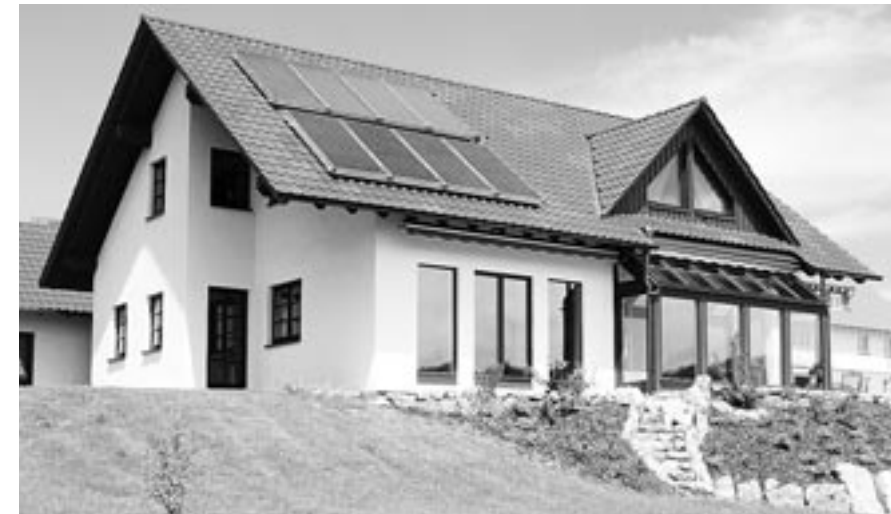
Die Solarkollektoren auf dem Hausdach übernehmen die Warmwasserversorgung. Foto: Viessmann (Schweiz) AG
