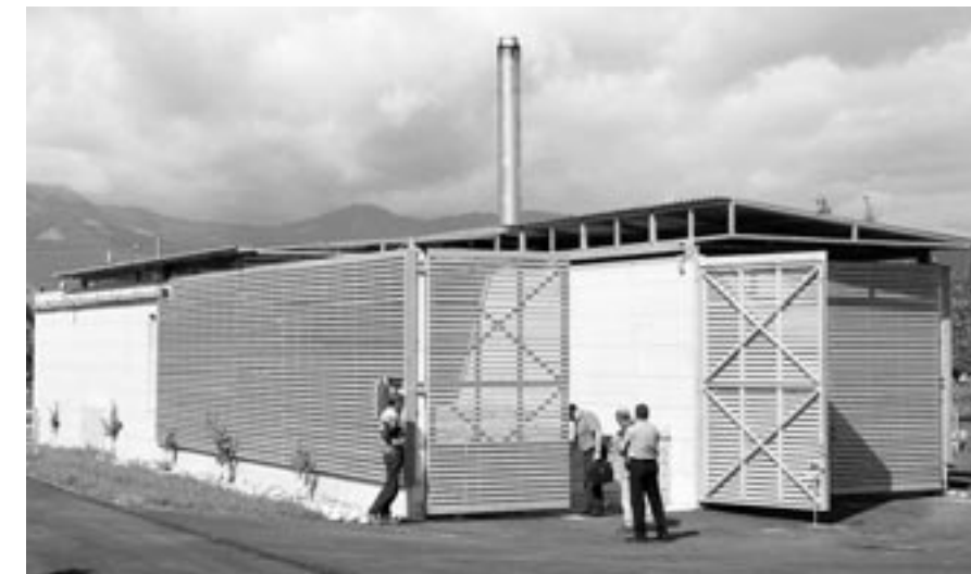
In der Schweiz ist ein grosses Potential an Möglichkeiten für Holzenergie-Nah- und -Fernwärme-Verbundnetze vorhanden, welches heute eindeutig zu wenig genutzt wird. Foto: Holzenergie Schweiz/zVg.
