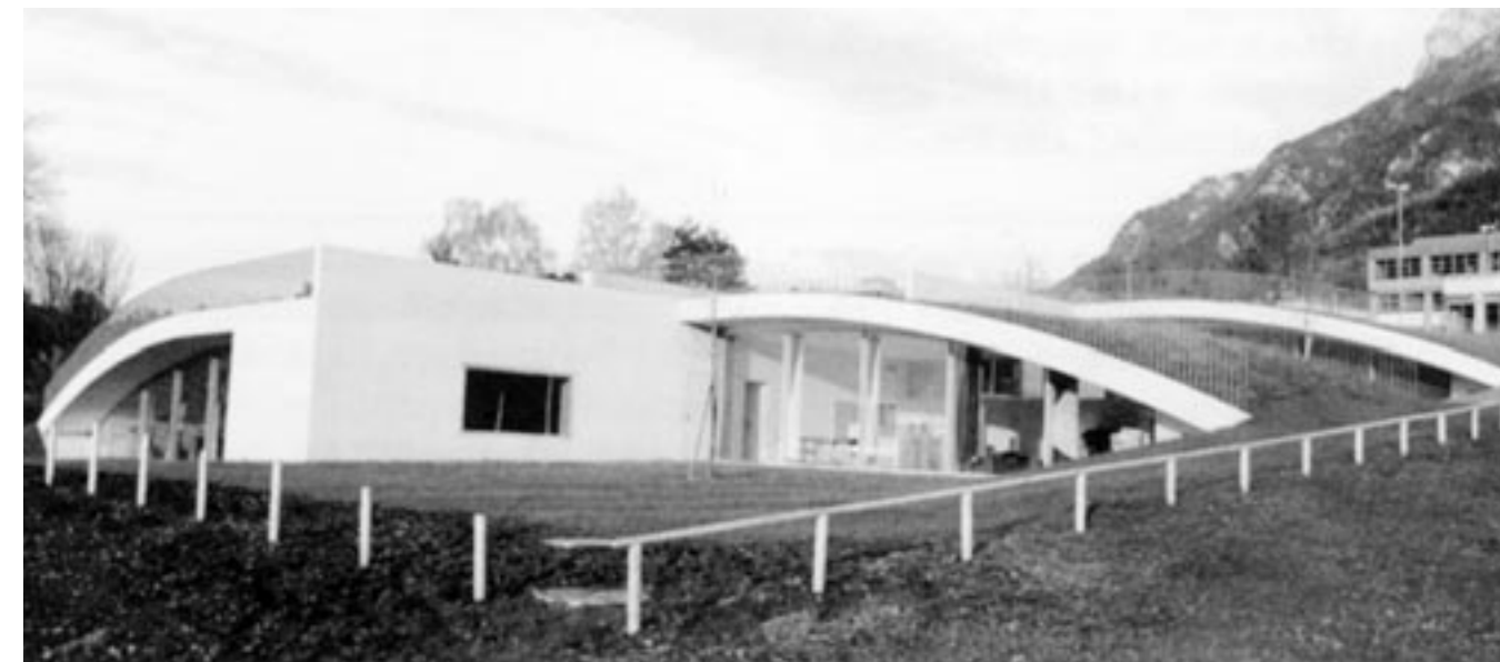
Der Kindergarten besticht nicht nur durch sein Energiekonzept.
