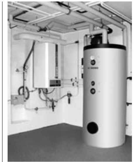
Brennwertkessel nutzen auch die Wärme aus dem Wasserdampf der Abgase. Bild: Montagebeispiel mit Wand-Brennwertkessel (links im Bild). Foto: Informationsstelle Heizöl
