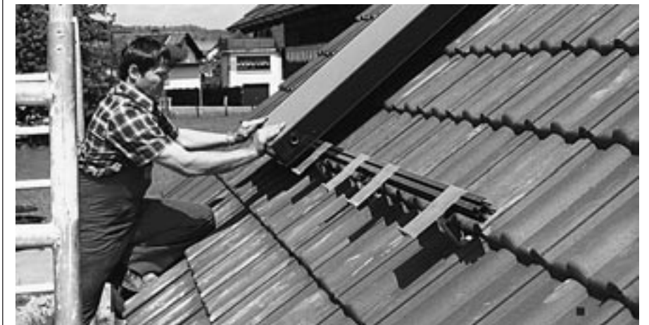
Dank Standardkomponenten ist die Montage der Solarmodule sehr einfach geworden. Foto: Viessmann (Schweiz) AG
