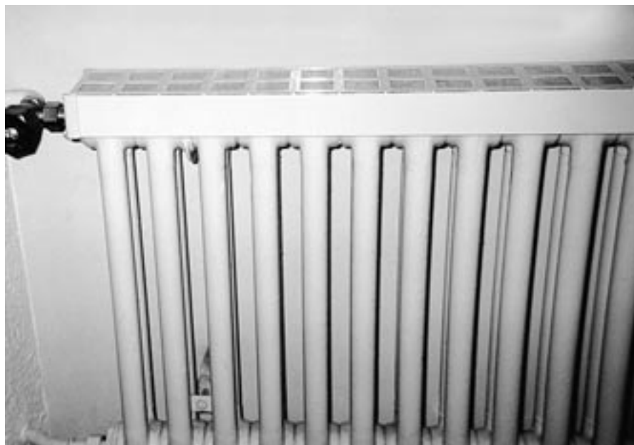
Rippenradiatoren eignen sich ausgezeichnet für Staubschutzfilter. Fotos: Electrosafe GmbH
