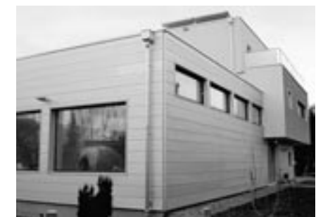
Das im Nordteil des Gebäudes gelegene Malatelier nutzt das Tageslicht durch gross dimensionierte Fenster und Oberlichter. Mit dem Einsatz von Passivhaus-Fenstern kann dieser Standard erreicht werden.
