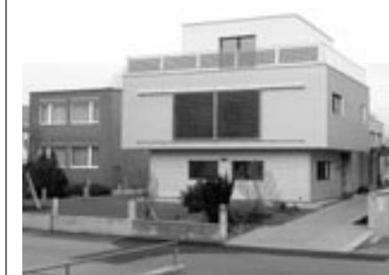
Die Südfassade des Passivhauses Schmözler in Pratteln ist mit integrierten Photovoltaik-Modulen ausgestattet.
