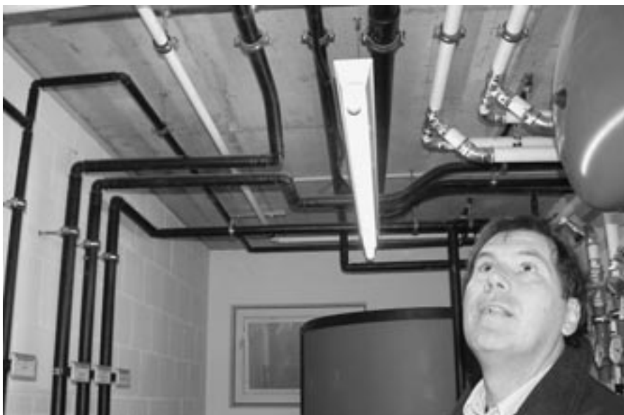
Ein Fachblick zur Decke: Rinaldo Cantoni, Rüefa-Cantoni Haustechnik AG, Wohlen und Fislisbach.
