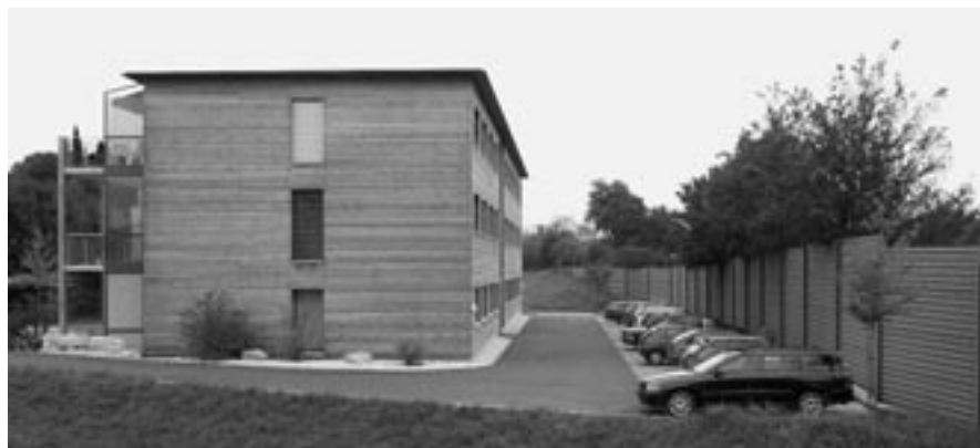
34 000 Autos brausen Tag für Tag hinter dieser Lärmschutzwand neben dem Wohn- und Bürohaus in Rapperswil vorbei. Dank Minergie® bleiben die Fenster den ganzen Tag zu und der Lärm und die schlechte Luft kommen nicht ins Gebäude. Die Komfortlüftung sorgt für ein gutes und gesundes Raumklima.
