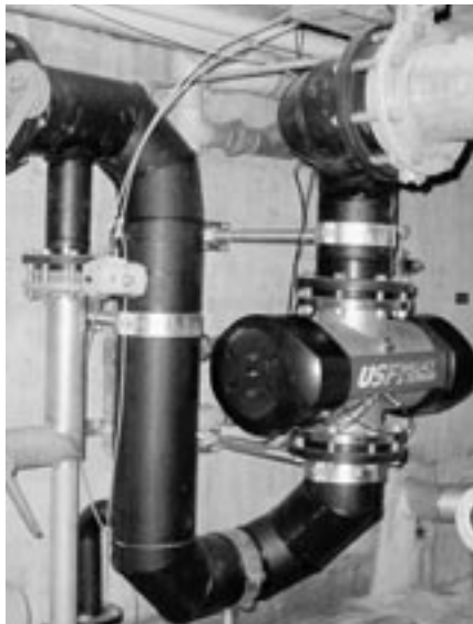
Abbildung 3: Eingebaute UV-Anlage.
