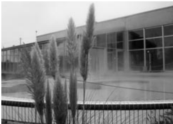
Hier wird auch im Winter im Freien im warmen Wasser geplänscht, dank einer Holz-Pelletsheizung. Bild: Gemeinde Dietlikon
