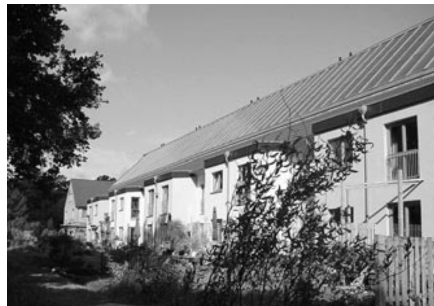
Energie vom Hausdach – mit Solarkollektoren kein Problem.
