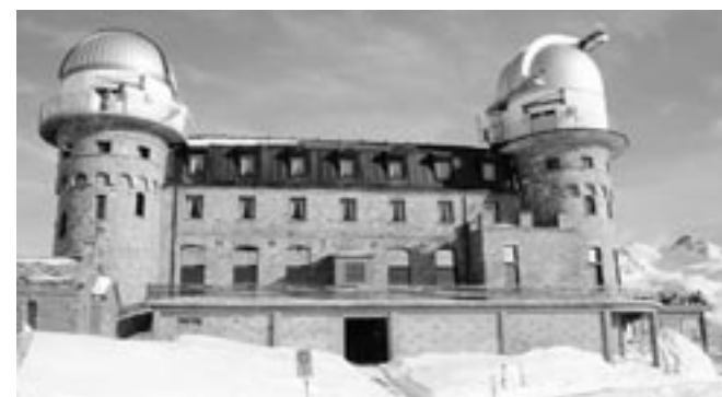
Wird saniert: Hotel Gornergrat Kulm, Zermatt, auf 3100 m ü. M.
