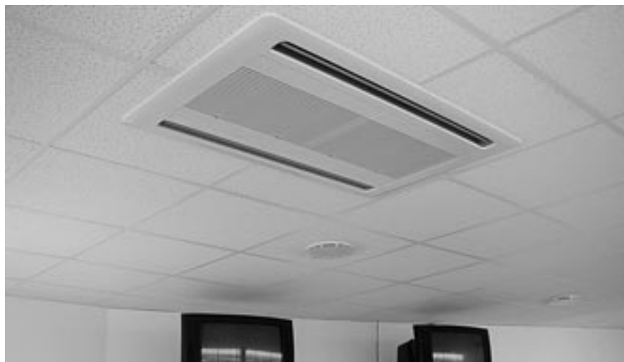
Decken-Split-Raumklimasystem (Inneneinheit).
