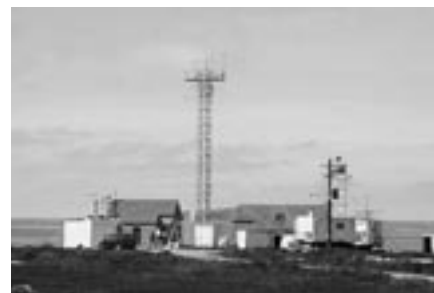
Mace Head ist die Messstation auf Meeresebene für Nordwesteuropa. Fotos: Empa
