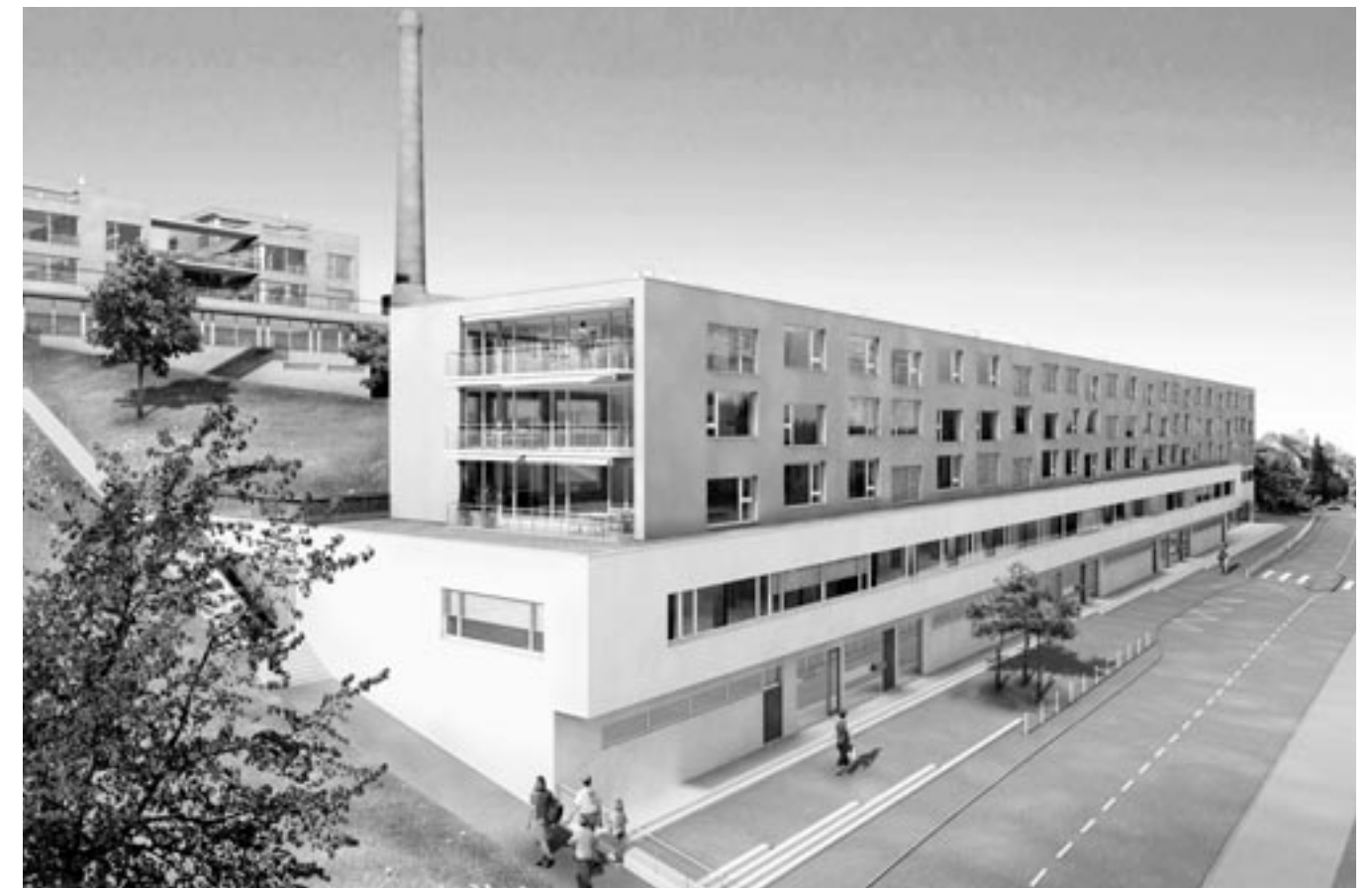
Aussenansicht Wohnüberbauung Lagomio in Wädenswil ZH – beheizt mit Wärme aus dem Zürichsee, mittels vier Wärmepumpen im EKZ-Contracting. Bilder/Schema: EKZ
