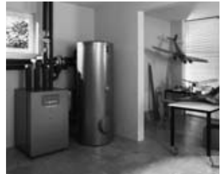
Modernisierung mit innovativer Technik leicht gemacht: Wärmepumpe für die Sanierung mit Vorlauftemperatur bis 65°C.
