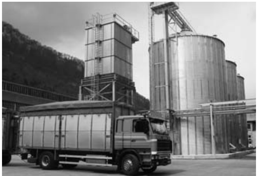
Holz-Pellet-Lager der AEK Energie AG in Balsthal: Wer jeweils bereits im Sommer Holz-Pellets kauft, profitiert von günstigeren Preisen und hilft, Versorgungs-Engpässe im Hochwinter zu vermeiden.
