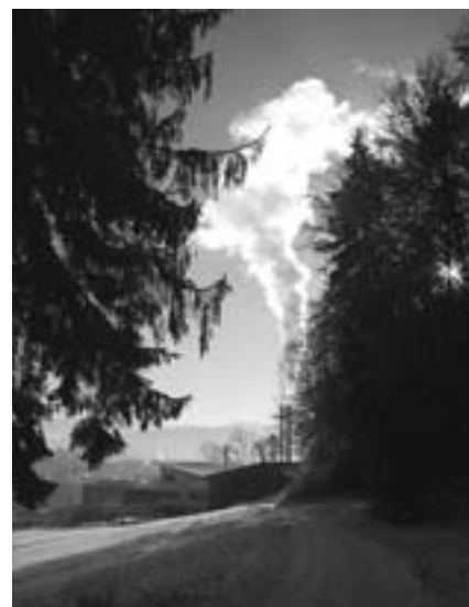
Die weisse Dampffahne gehört seit 1999 zur Landschaft von Pruntrut. Dank Elektrofiltern werden von der «Thermoréseau»-Anlage nur 6 mg Feinstaub ausgestossen. Dies ist achtmal weniger als die gesetzlich zulässigen 50 mg/m 3 bei Anlagen ab 5 MW Leistung.
