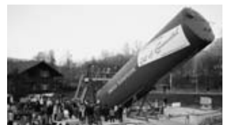
Aufstellen des Solarspeichers auf der Baustelle (19.11.05).
