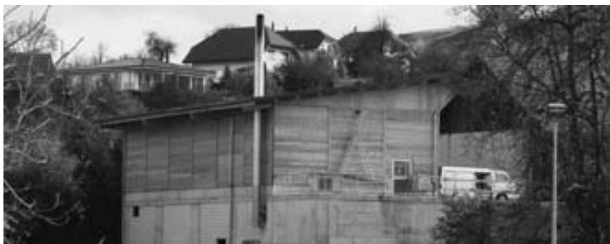
Der Holzenergie-Wärmeverbund «Lindhübel» der Gemeinde Dürrenäsch wurde mit dem Holzpreis des Aargauischen Waldwirtschaftsverbandes (Sektion Forstkreis 4) ausgezeichnet. Bild: Das neue Gebäude mit der Energiezentrale aus Nordwesten. Im Untergeschoss befindet sich die Holzsnitzelfeuerung, oben die Altstoffsammelstelle. Foto: z.V.g.
