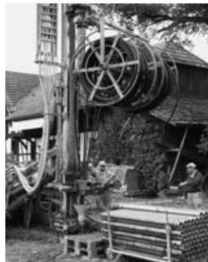
Erdwärme-Nutzung: im Bild die Bohrung für eine Erdsonde. Bild: Archiv OeJ
