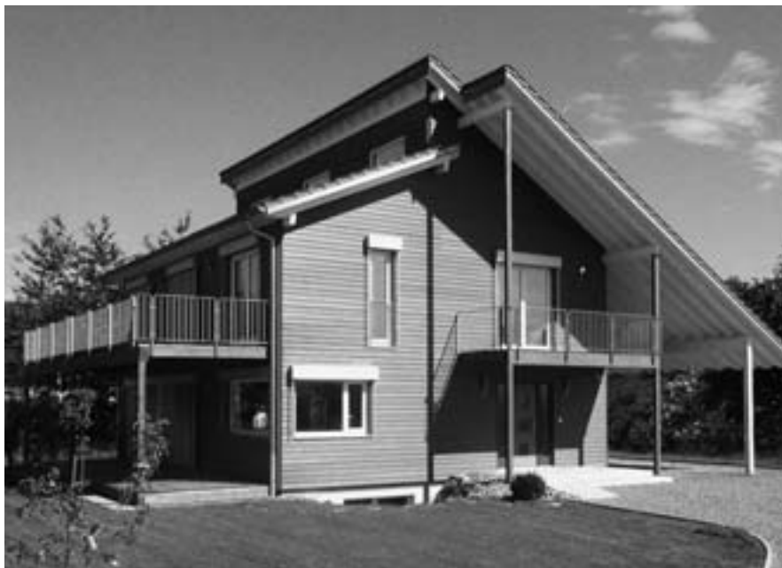
Das erste und derzeit einzige Schweizer Klimaschutzhaus der Baufritz AG, Amsoldingen/Thun BE, steht in Lupfig AG.
