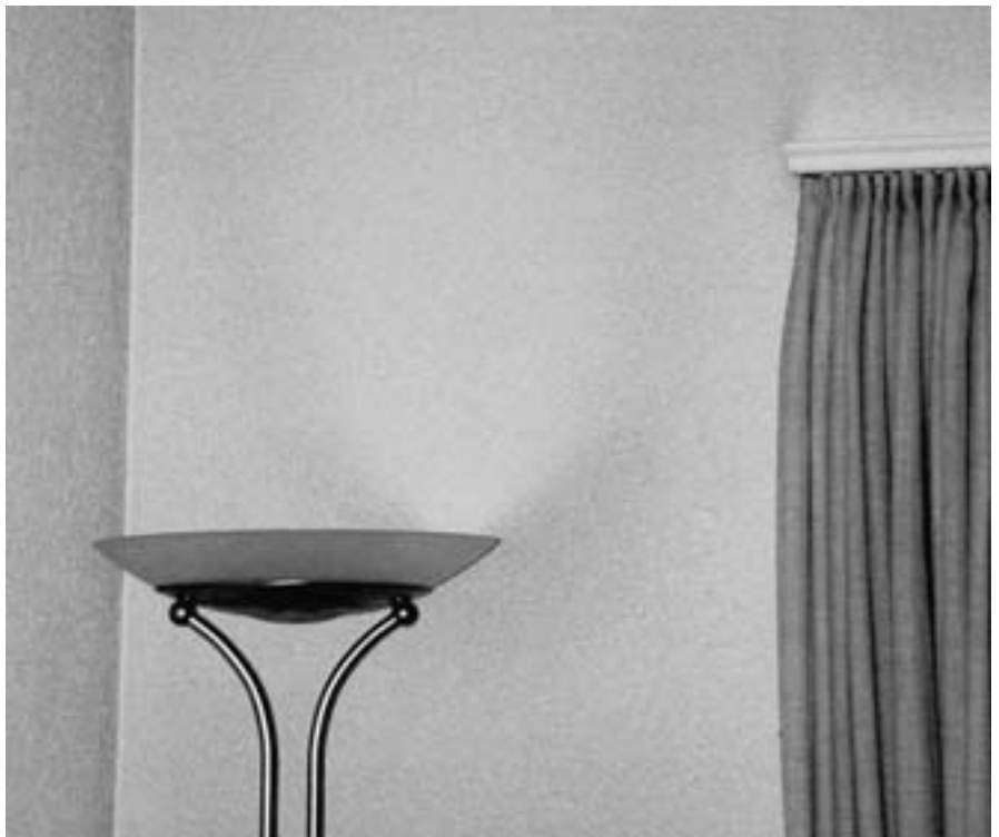
Plötzliche schwarze Verfärbungen in neuen oder in renovierten Wohnungen – wie hier im Bild gezeigt, über einer Halogenlampe – geben oft Rätsel auf und führen nicht selten zu Diskussionen über die Haftung. Foto: Empa
