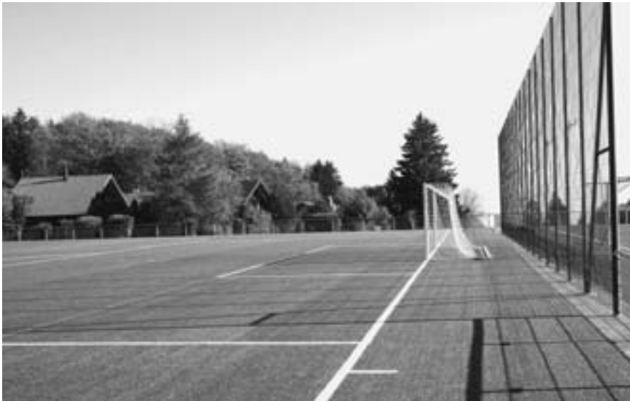
Kunststoff-Rasenfeld (Trainingsplatz 2) mit umlaufendem Beton-Sickerstreifen und integriertem Ballfang- und Einfassungs-Zaun.
