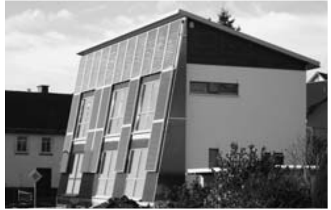
Die 6,8 m 2 Absorberfläche der Sonnenkollektoren decken 63% des Warmwasserbedarfs in diesem Minergie-P-Haus in Dürnten FR. Die restlichen 47% liefert der Pellet-Ofen. Bild: Schwaller
