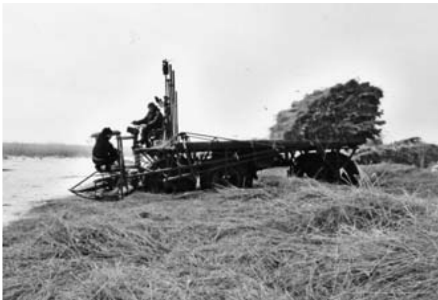
Arbeiter beim Abladen des Schilfs.
