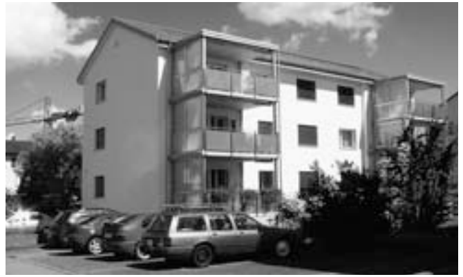
Nach der ersten Erneuerungsetappe erscheint das 6-Familienhaus in Staufen mit Baujahr 1967 bereits in einem neuen Glanz.
