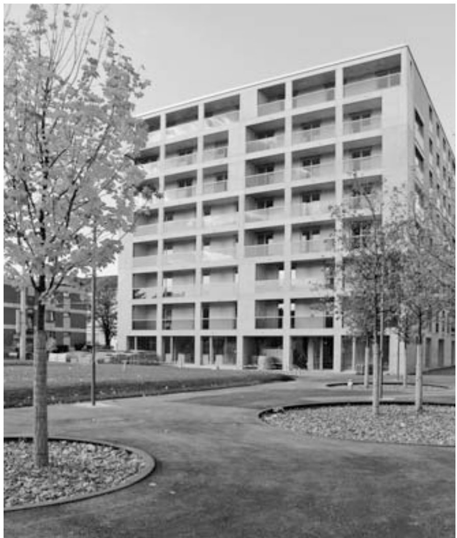
Die 152 Wohnungen der neuen Siedlung «Werdwies» in Zürich-West liegen bezüglich Energieverbrauch weit unter dem «Minergie»-Standard. Möglich ist diese Qualität auf Grund der guten Wärmedämmung, der mechanischen Lüftung und der äusserst kompakten Bauweise.
