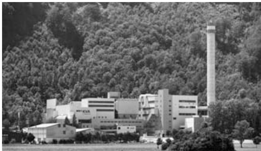
Innovative Messtechnik stellt bei modernen Kehrrechtverbrennungsanlagen sicher, dass kaum noch Schadstoffe emittiert werden. Im Bild die KVA Niederurnen.
