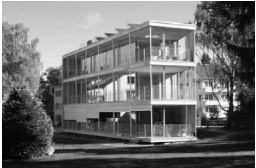
Dieses Dreifamilienhaus im Berner Liebefeld-Quartier beruht auf einer Sandwich-Struktur aus Dämmplatten, Dämmsteinen und aus Holz. Dieses vorbildliche Gebäude hat das erste «Minergie-P-Eco»-Label der Schweiz erhalten.
