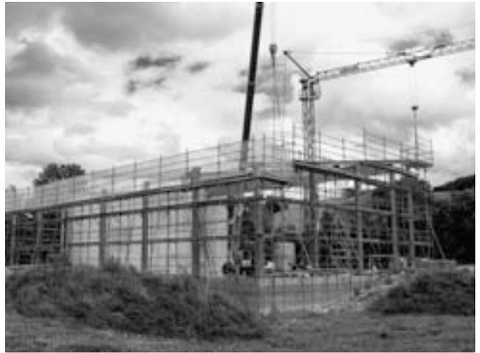
Bau-Phase: Die Stahl-Konstruktion der Holzschnitzel-Lagerhalle (unmittelbar neben der Heizzentrale) wird aufgerüstet.
