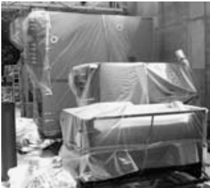
Rohbau-Phase Heizzentrale mit dem angelieferten grossen und dem kleinen Holzheizkessel sowie dem Ölheizkessel (von hinten nach vorne).
