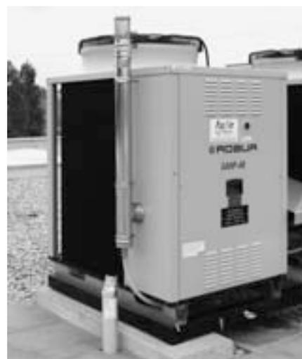
Eine der drei reversiblen Gas-Wärmepumpen/Kälteerzeuger auf dem Dach des Werkhofs.
