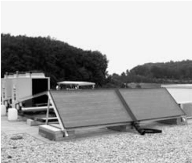
6 m<sup>2</sup> Solarkollektoren decken 60% des Warmwasser-Bedarfs.
