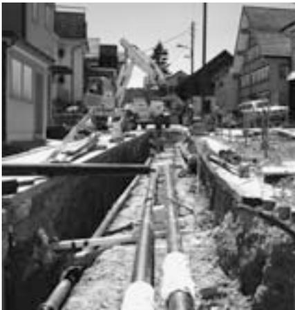
Bau-Phase: Die isolierten Stahlrohre des Wärmeverbunds werden verlegt.
