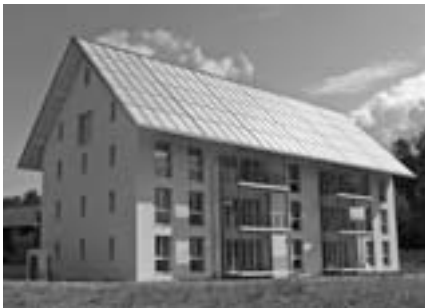
Das Solarhaus im August 2007.
