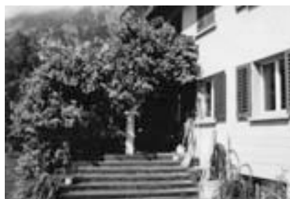
Der Ausstieg des Heizkessels veranlasste die Bauherrschaft dieses Haus in Walenstadt SG dazu, ein Erneuerungskonzept zu erstellen. Das Resultat: 80% weniger Heizenergieverbrauch und mehr Wohnkomfort.
