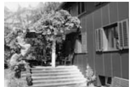
Das nach der Modernisierung gut gedämmte Einfamilienhaus in Walenstadt wird nun mit einem Pelletsofen und mit Solarkollektoren beheizt.
