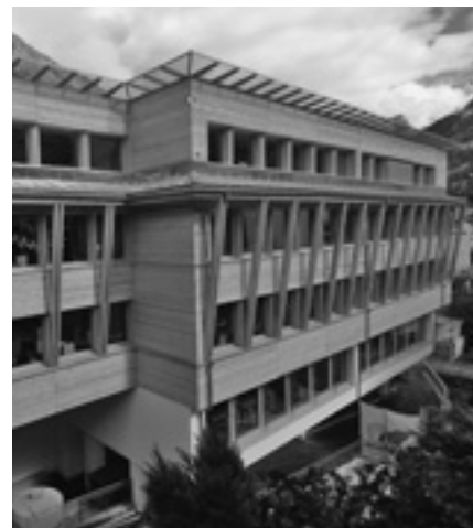
Das EWZ-Verwaltungsgebäude in Zermatt im Wallis – ein Minergie-P-Gebäude.
