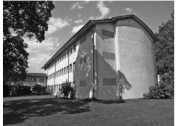
Sieht gleich aus wie das Original, ist aber komfortabler und energieeffizienter: das modernisierte Schulhaus Kreuzfeld in Langenthal.
