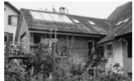
Sonnenkollektor-Anlage auf EFH.
