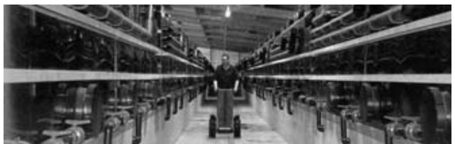
600 Fischbecken mit den umfangreichen Versorgungs- und Verbindungsleitungen.
