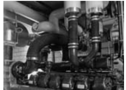
BHKW-Gruppe mit V12-Zylinder-Zündstrahl-Dieselmotor.
