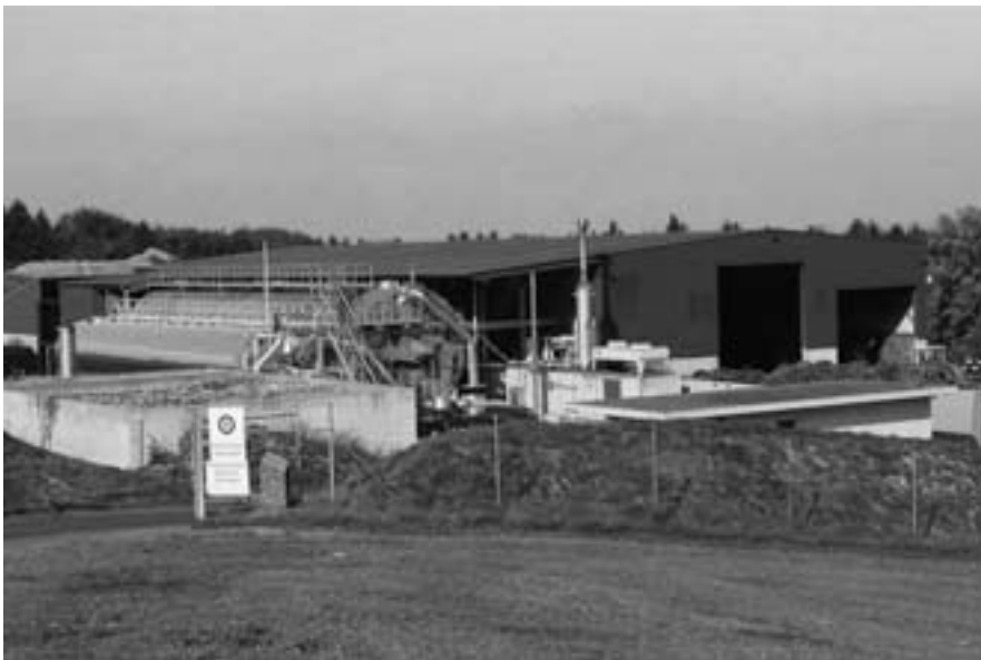
Gesamtansicht der Vergärungsanlage Chrüzlen.
