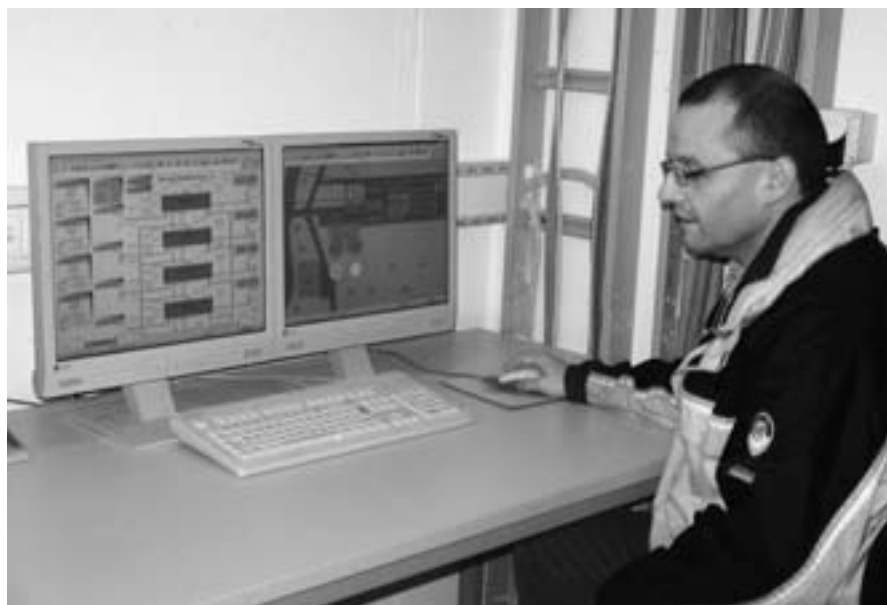
Marcel Schöb, Projektleiter der IBG Graf AG, St. Gallen, am Bildschirm zur Gesamtanlagen-Steuerung.
