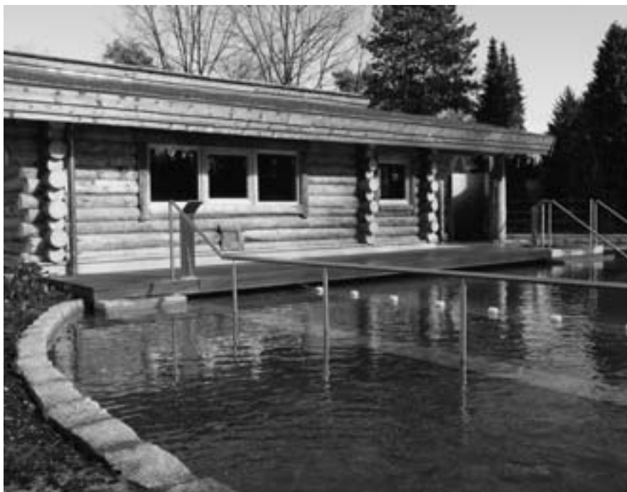
Der seit Februar 2008 geöffnete Saunagarten erweitert die Saunawelt der Therme.
