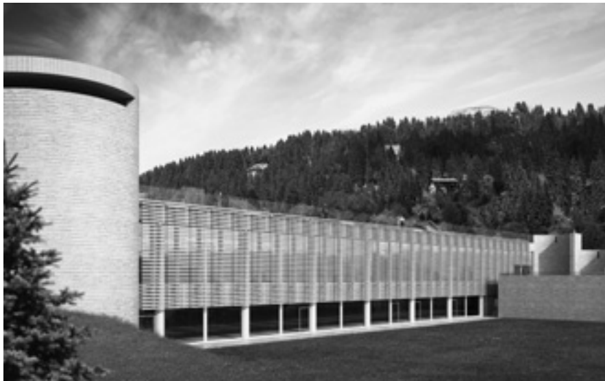
Das neue Bad auf der Rigi wird unter den neu gestalteten Dorfplatz zu liegen kommen; der Zugang befindet sich im Turm links.
