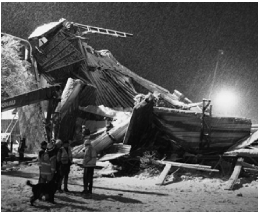
Unter der Last von nassem Schnee stürzte bekanntlich das Dach der Eishalle Bad Reichenhall (D) im Januar 2006 zusammen und begrub Dutzende Menschen unter sich. Zwölf Kinder und drei Erwachsene konnten nur noch tot geborgen werden.
