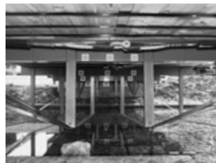
Verformungs-Messungen mit einem Video-System an einer Brett-schicht-Holzbrücke, welche mit speziellen, an der Empa entwickelten, Zugbändern aus kohlenstofffaser-verstärktem Kunststoff (CFK) unterspannt ist.
