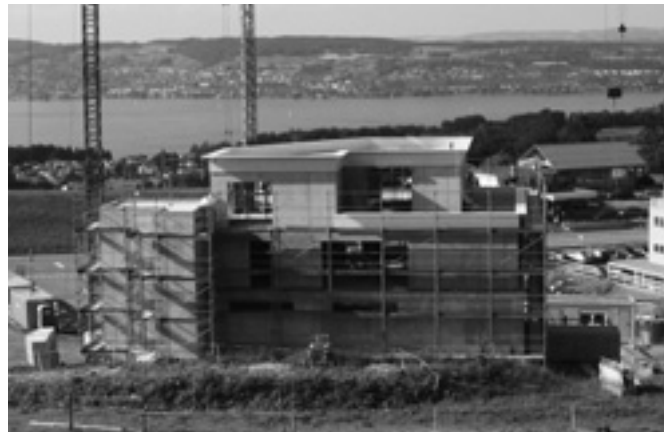
Blick auf die Baustelle des neuen Minergie-P-Hauses (Teil-Etappe während der Bau-Phase), welches hoch über dem Zürichsee – unterhalb des Hotels Panorama Resort & Spa – in Feusisberg SZ zu stehen gekommen ist.
