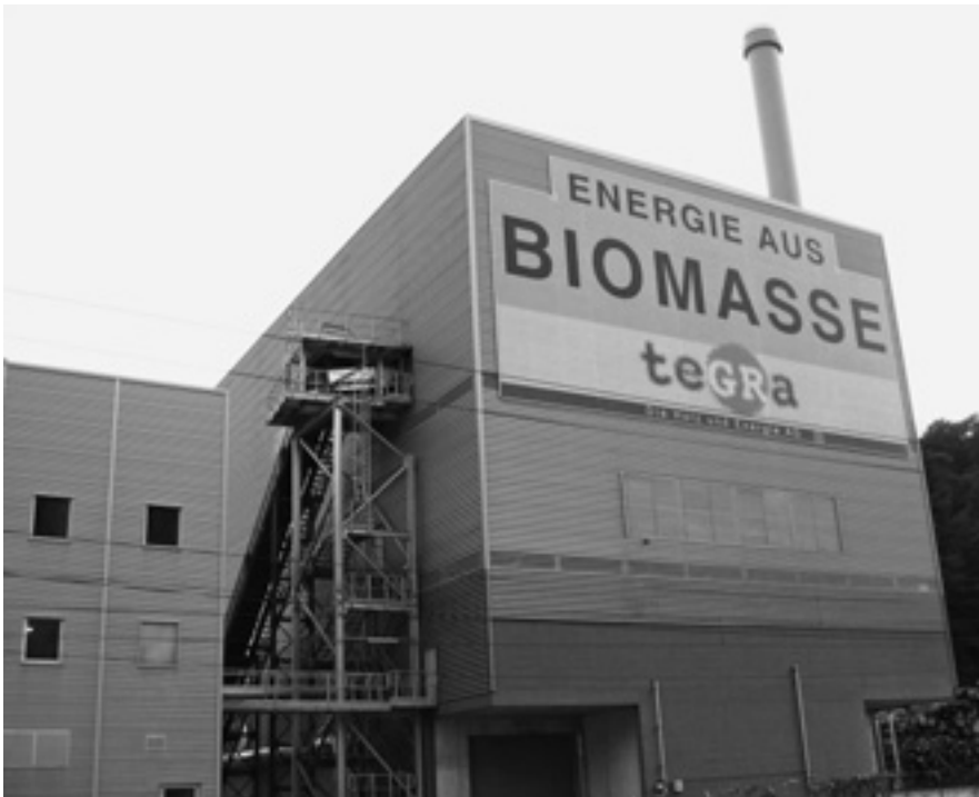
Verwaltungszentrum und Block 3 des Biomasse-Kraftwerkes der TEGRA Holz & Energie AG in Domat/Ems GR.
