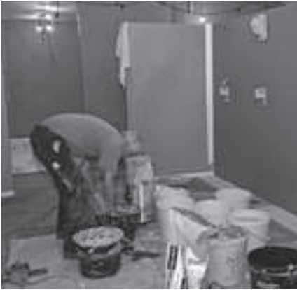
Erneuerung der Duschen.
