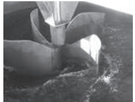
Das erste Pilot-Wasserwirbelkraftwerk der Schweiz in Schöffland AG produziert bereits seit längerer Zeit Strom im Einklang mit der Natur. Der Beckendurchmesser der Anlage beträgt 6,5 m und die Fallhöhe 1,5 m. Bilder: Chris Regez/GWWK
