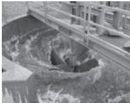
Das erste Pilot-Wasserwirbelkraftwerk der Schweiz in Schöffland AG produziert bereits seit längerer Zeit Strom im Einklang mit der Natur. Der Beckendurchmesser der Anlage beträgt 6,5 m und die Fallhöhe 1,5 m. Bilder: Chris Regez/GWWK
