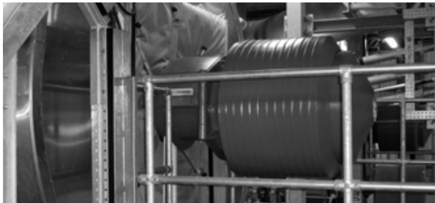
Blick auf den Industriebrenner cib der Costerm Swiss AG (im Bild mit Schalldämmgehäuse) für die Heissgas-Erzeugung aus Erdgas N. Bilder: Costerm Swiss AG
