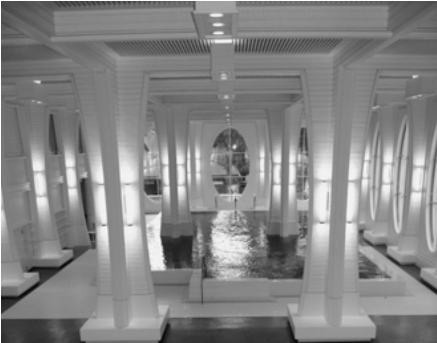
Das 36.5 °C warme Wasser wird in der 4.5 Kilometer entfernten Tamina-Schlucht gefasst und mittels einer Leitung zu den verschiedenen Nutzern geführt.
