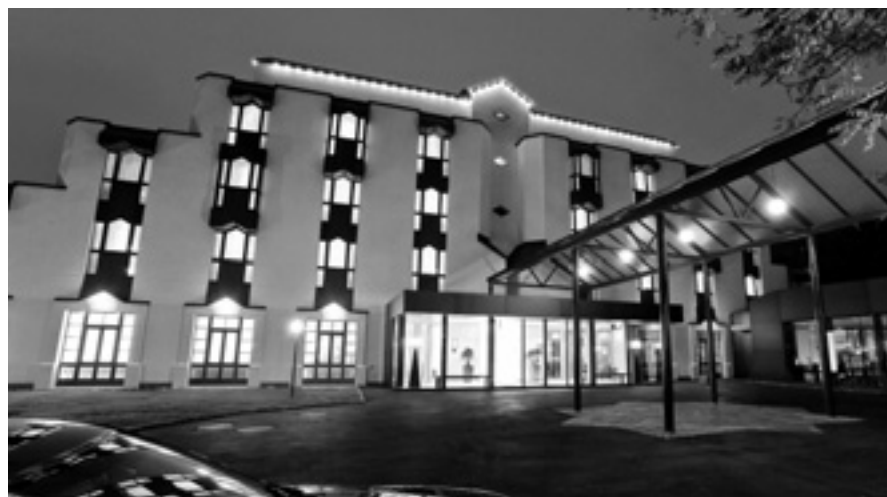
Mit einem Investitionsvolumen von rund 14 Millionen Franken wurde das Vier-Sterne-Hotel Sântispark einer Totalerneuerung unterzogen.
