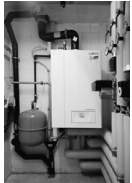
Gas-Kondensationskessel sparen nur Energie, wenn der Rücklauf tief genug ist. Links unten am Kessel zu sehen: der Kondensatablauf (in Trichter).
