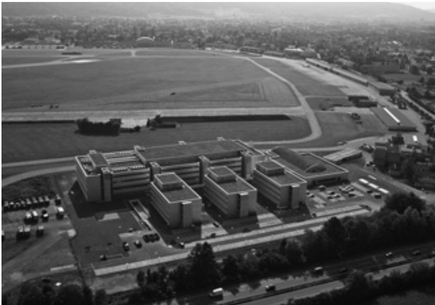
Um den Betrieb des neuen Skyguide Air Navigation Service Centers in Wangen-Dübendorf ZH garantieren zu können, mussten hohe Anforderungen an die Energieversorgung in den Bereichen Wärme, Kälte und Elektrizität erfüllt werden.
