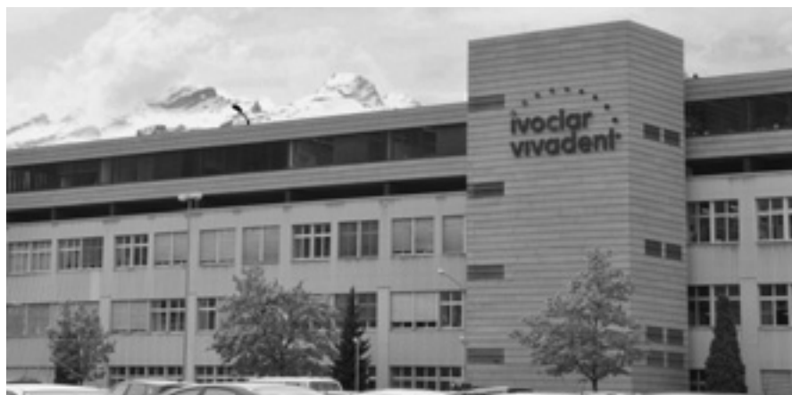
Spezielle Gelblicht-Verkleidungen an den Fenstern: Die Ivoclar Vivadent AG in Schaan FL verarbeitet Pasten, die bei Tageslicht aushärten. Die Gelblicht-Folien filtern die normale UV-Strahlung aus dem Tageslicht heraus. Die Aufnahme täuscht, innen brennen ganz normale Lampen.
