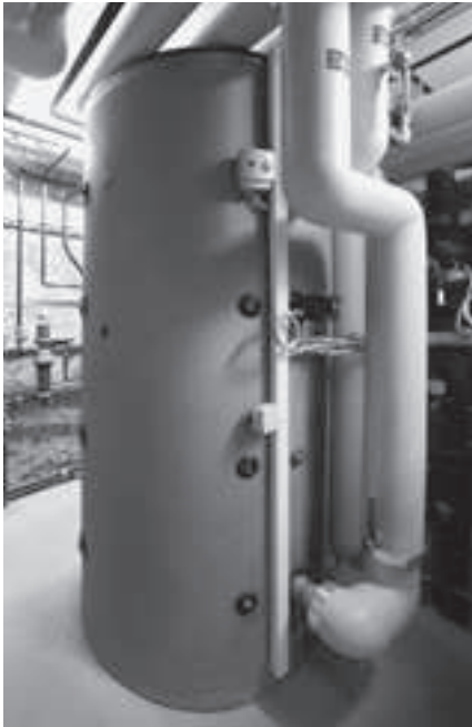
Während der Sperrzeiten für Strombezug deckt ein Pufferspeicher mit 1000l Inhalt temporär den Bedarf an Raumwärme ab.
