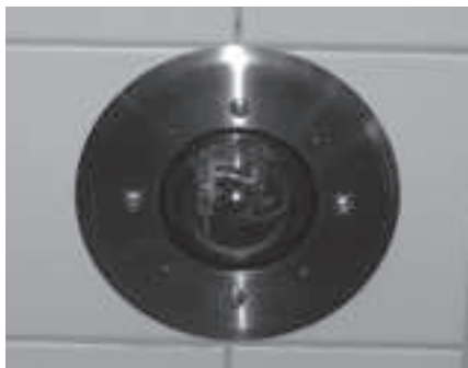
Fertig eingebaute Kamera.
