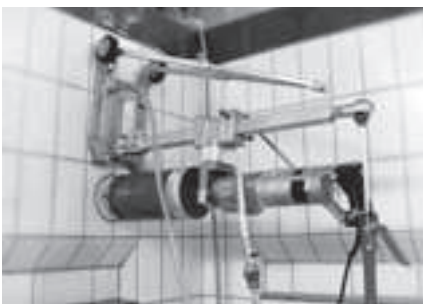
Einbau von Unterwasserkameras in eine Beckenwand. Bild: Kernbohrung für den Einbau der Kamera.
