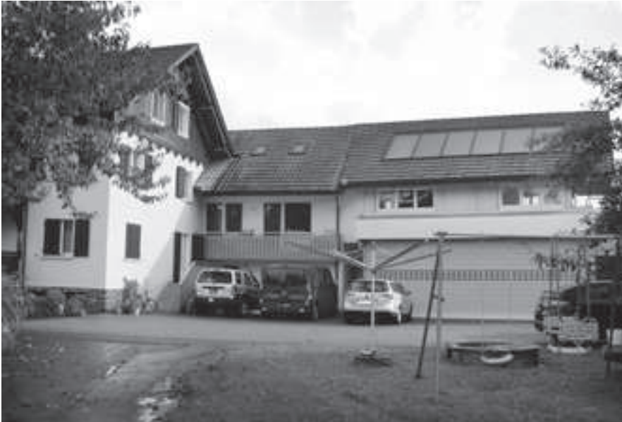
Kaminfeger Andreas Marock heizt sein Wohnhaus und die Werkstatt mit Holz, Pellets und Solar in einer Kombianlage. Bilder: Chris Regez/Windhager/z.V.g.
