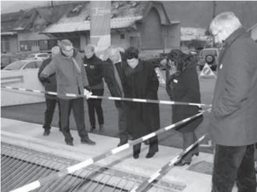
Die Forstbetriebsgemeinschaft Balsthal/Mümliswil-Ramiswil liefert das für den Betrieb der Heizzentrale benötigte Holz. Bild: Einfüllöffnung des unterirdischen Holzschnitzel-Bunkers.
