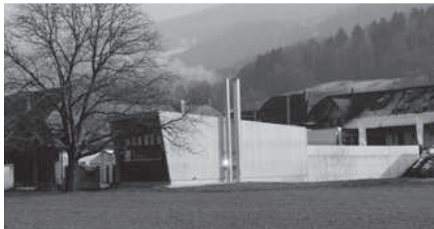
Heizzentrale Balsthal SO (Bild) mit AEK-Fernwärmenetz: 80 Prozent der benötigten Energie werden durch eine CO 2 -neutrale Holzschnitzelfeuerung bereitgestellt.
