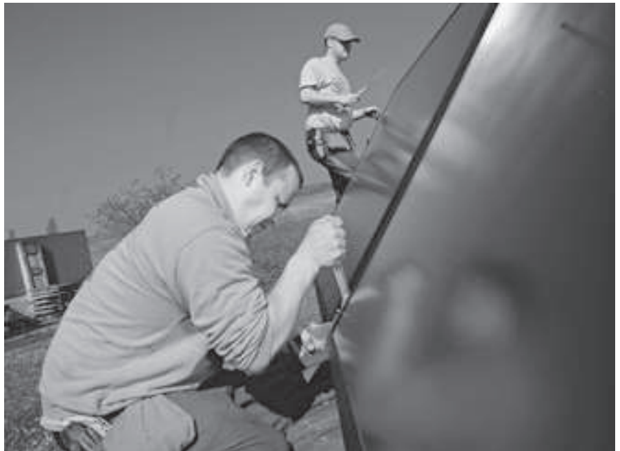
Sonnenkollektoren-Montage auf dem Dach.
