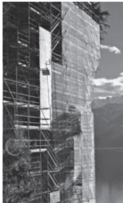
Die SBB erneuert seit Herbst 2010 die Felswandsicherungen am Ölberg oberhalb der Axenstrecke bei Morschach SZ.
