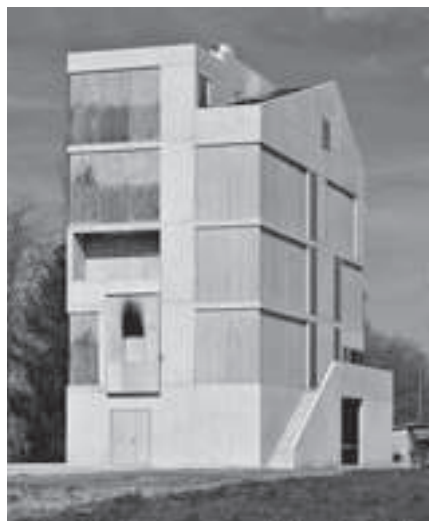
Das neue Brandhaus II im Ausbildungszentrum Rohwiesen (AZR) der Stadt Zürich in Opfikon ZH, Ansicht von Süden. Bilder: Theodor Stalder/Stadt Zürich/z.V.g.
