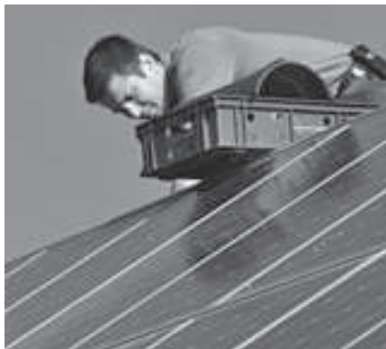
Montage einer Photovoltaikanlage
