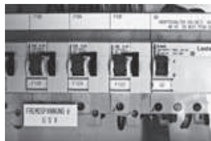
Die neue Suva-Broschüre «Elektrizität – eine sichere Sache» zeigt unter anderem, weshalb Fehlerstromschutzeinrichtungen zwar gerade für Laien eine geniale Einrichtung sind – aber keinen 100-prozentigen Schutz bieten. Bilder: Suva
