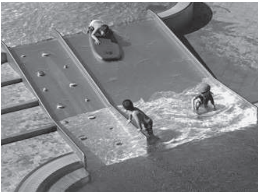
Die Kinderplanschbecken sind als Edelstahlbecken ausgeführt.
