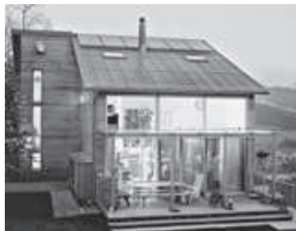
Im Minergie-Haus der Familie Schlatter-Boesch aus Luven GR werden Raumwärme und Warmwasser in einer bivalenten Heizanlage mit 16.8 m 2 Sonnenkollektoren und einer Pellet-Zentralheizung erzeugt. Bild: Daniel Thuli, Ilanz GR
