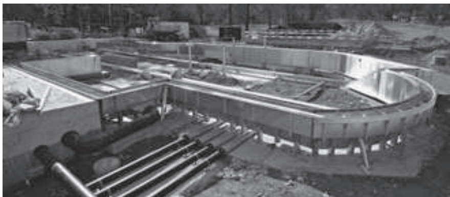
Bauphase Neubau: Montage des Edelstahl-Beckenkörpers von Berndorf Bäderbau auf Streifenfundamente.
