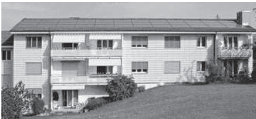
Auf den Dächern der Siedlung Höhenring in Zürich-Seebach hat die Baugenossenschaft Milchbuck für die Warmwasseraufbereitung der 60 Wohnungen 81 m 2 Sonnenkollektoren montiert.
