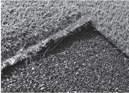
Die Rasenbahnen werden mit PU-Leim auf einem Klebstoffträger verbunden, sodass das ganze Feld schwimmend verlegt werden kann. Bilder: Empa/Tisca Tiara
