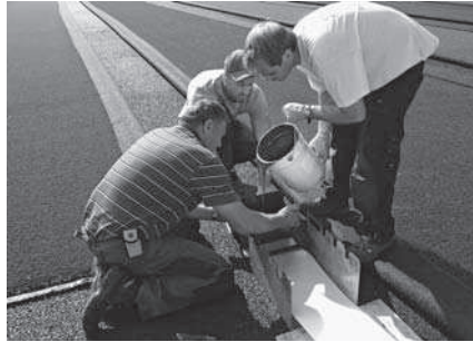
Die Rasenbahnen werden mit PU-Leim auf einem Klebstoffträger verbunden, sodass das ganze Feld schwimmend verlegt werden kann. Bilder: Empa/Tisca Tiara
