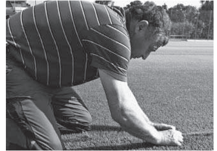
Die Rasenbahnen werden mit PU-Leim auf einem Klebstoffträger verbunden, sodass das ganze Feld schwimmend verlegt werden kann. Bilder: Empa/Tisca Tiara
