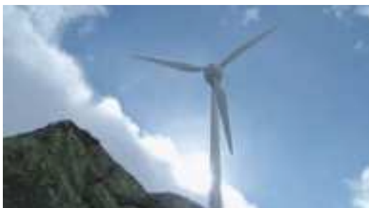
Windturbine auf dem Gütsch ob Andermatt UR.
