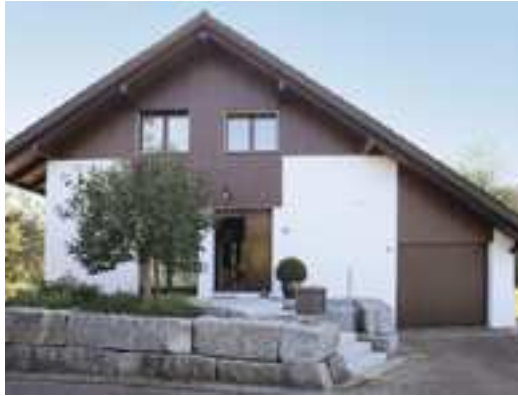
In diesem Einfamilienhaus in Zofingen AG ist die erste zeoTHERM Anlage der Schweiz installiert.
