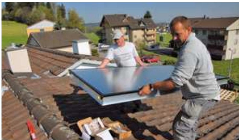
Solarteure haben die Sonne und andere erneuerbare Energie im Fokus. Bild: Montage einer thermischen Solaranlage.
